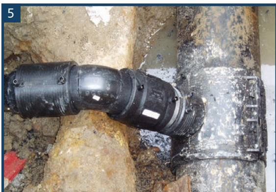
5 PE100 SDR11 16bar D280분기 핀란드 D280에서 D110 새들분기
