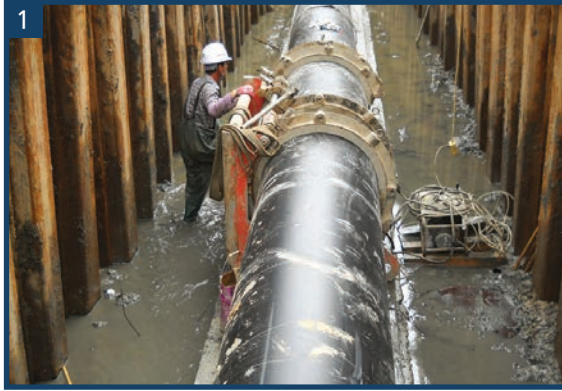
1 PE100 SDR17 10bar D800 울산광역시 여천천 압송관로 공사
