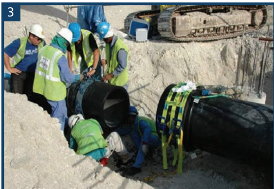
3 PE100 SDR11 16bar D630 두바이 Palm Island 현장 전자소켓 융착
