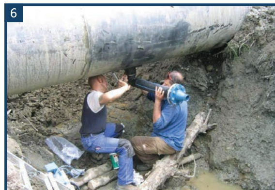
6 PE100 SDR11 16bar D800 이탈리아 D800에서 D110 새들분기
