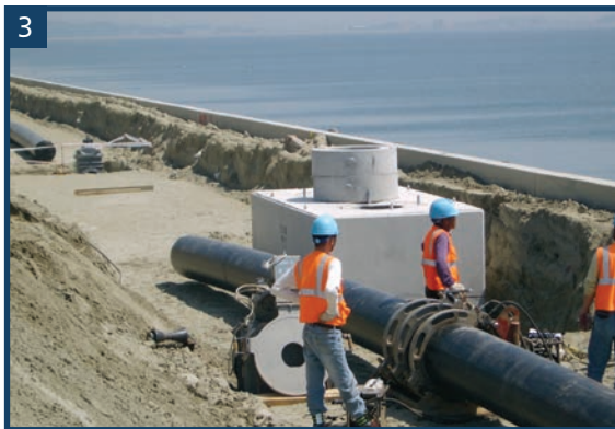
3 PE100 SDR17 10bar D560 한국농어촌공사 새만금 현장
