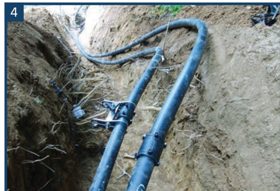
4 PE100 SDR11 16bar D63 충남 연기군 수도시설 틀관공사
