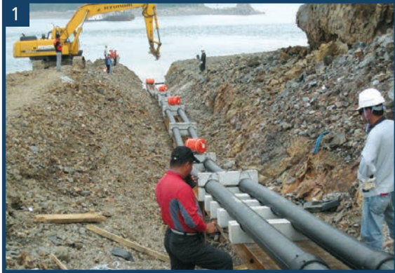
1 PE100 SDR11 16bar D225 당진 난지도 해저관로 현장
