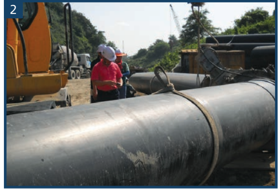
2 PE100 SDR17 10bar D800 울산광역시 여천천 압송관로 공사
